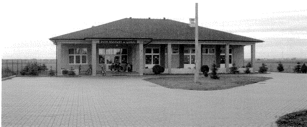
Świetlica wiejska „Dom Kultury”
