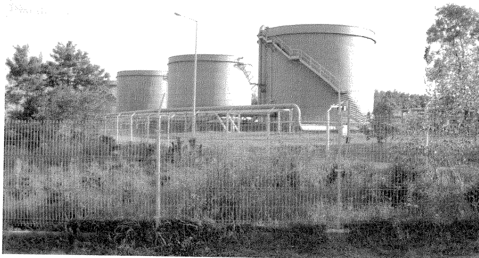
Instalacje kopalni soli
