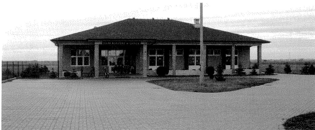
Świetlica wiejska „Dom Kultury”
